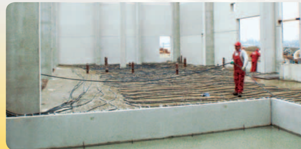
Površinski grijač HSH 700 zagrijava beton na njegovu idealnu temperaturu otvrdnjavanja od 18 - 24 °C i pritom štedi vrijeme i novac.
